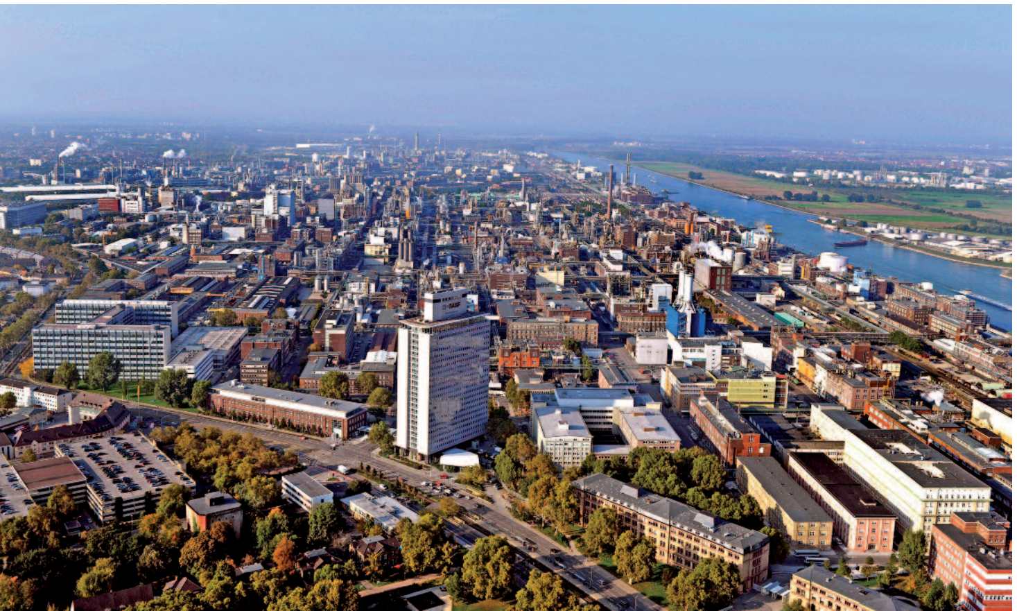
Stammwerk der BASF Gruppe - Ludwigshafen
